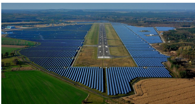
ENFO AG 155 MW Solarpark Neuhardenberg (2012)
